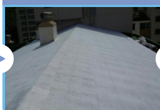
싱글용 방수시트 시공
