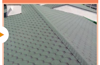
싱글 시공 완료
